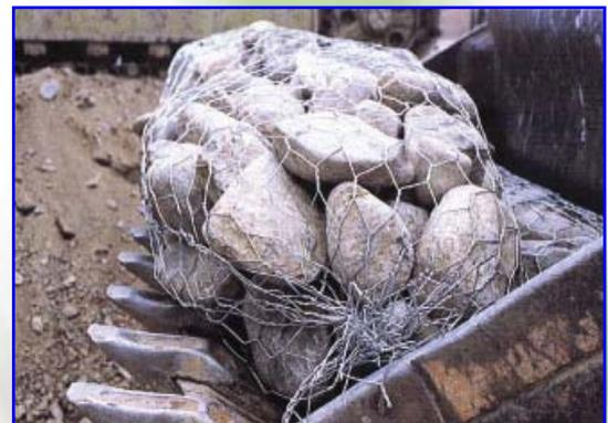
**Foto 1 –** Herstellung eines „Steinzylinders“ und Lagerung auf einer Baggerschaufel zur Verlegung
