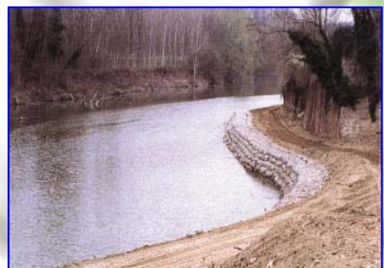
**Foto 2 –** Errichtung eines hydraulischen Uferschutzes aus zylindrischen Gabionen
